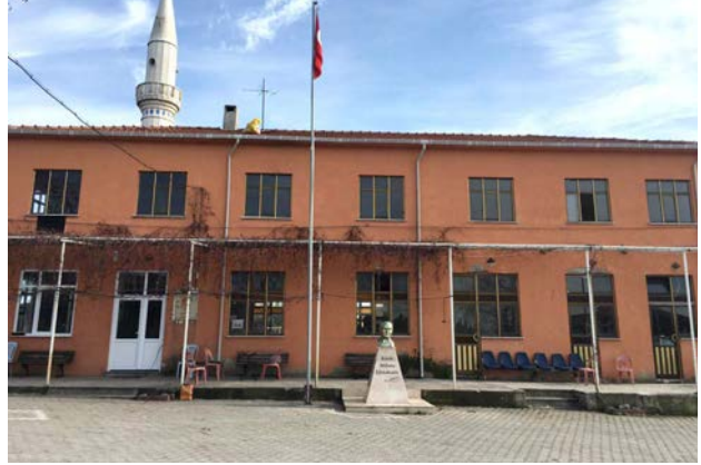
• Köteyli Köy Konağına Bakım Onarım
