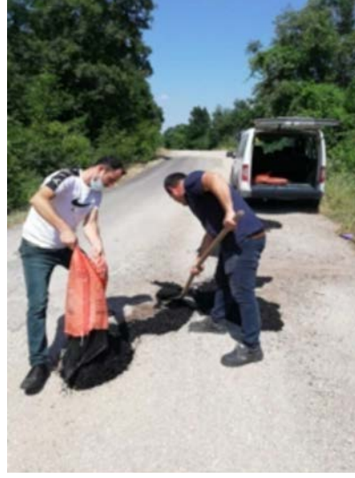
11. Tesisimiz yolu üzerinde oluşan çukurlar sıcak asfalt ile dolduruldu.
